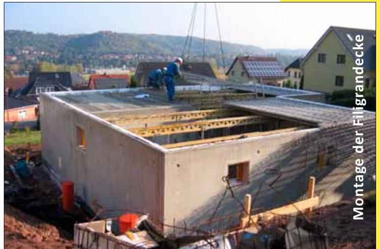
Betonage der Wände und Decke
